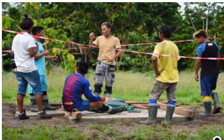
Le chantier-école à Taluen a permis aux six stagiaires de participer à l'amélioration du cadre de vie dans leur village © S. Bouillaquet/PAG
