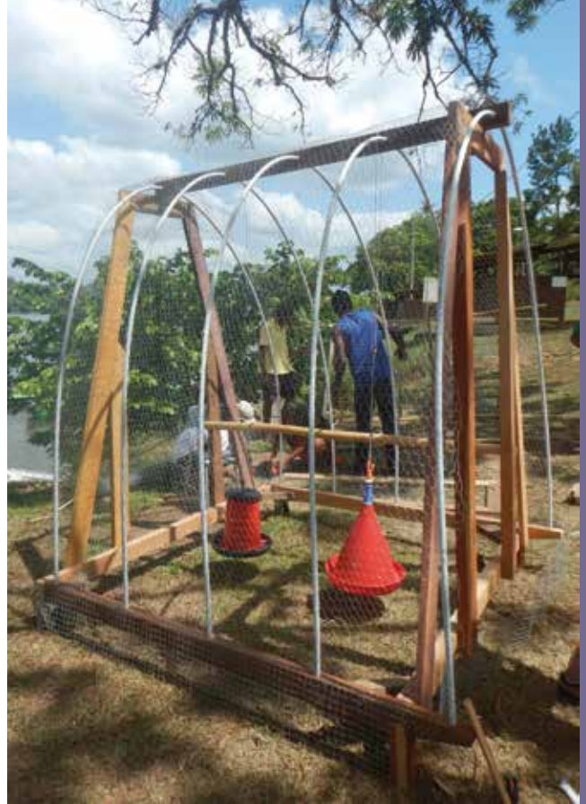
▲ Construction d'un poulailler mobile et duplicable © SA / PAG
