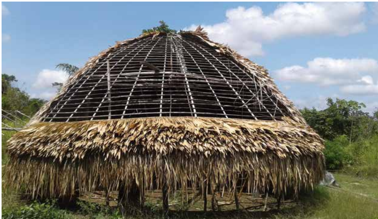
▲ La construction du carbet de Cayodé doit s'achever en janvier 2017 © OS / PAG
