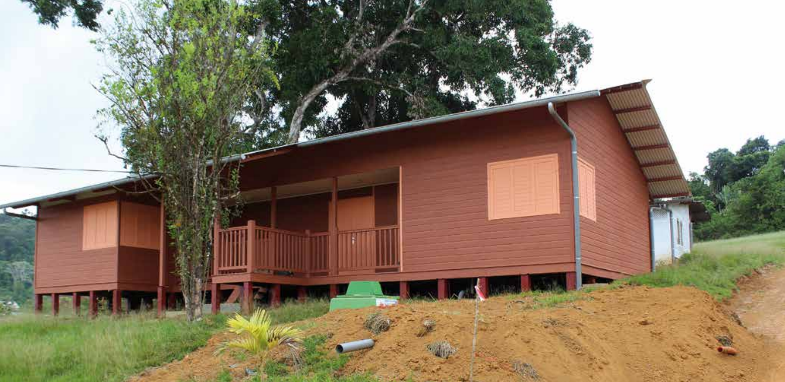
▲ Le chantier de La Maison du Parc à Saül va être réceptionné début 2016. © PAG
